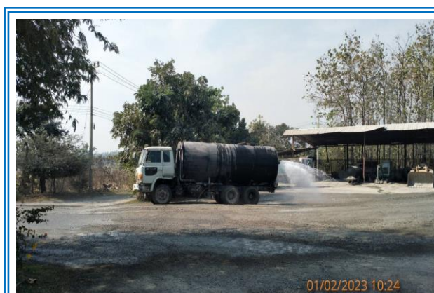
รูปที่ 3-6 การฉีดพรมน้ำ เพื่อลดการฟุ้งกระจายของฝุ่นละออง ภายในพื้นที่โครงการ
